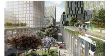
Transformación de la estación de Eindhoven
