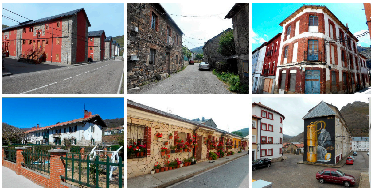
Figura 3. Modelos edificatorios: cuarteles (Villaseca de Laciana, 1916-1945, arriba izda.); construcción tradicional tardía (Villaseca de Abajo, 1920, arriba centro); casa con cercos de ladrillo (Santa Lucía, 1930, arriba dcha.); viviendas para empleados (Sabero, 1940, abajo izda.); colonia de casas económicas (Matarrosa del Sil, 1955, abajo centro); bloques de orden abierto -Colominas- (Ciñera, 1962, abajo dcha.). Fuente: fotos de los autores.
