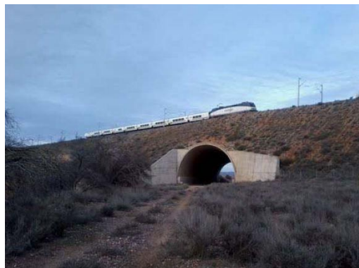
Cruce del viejo trazado de Ciudad bajo la nueva vía del AVE
