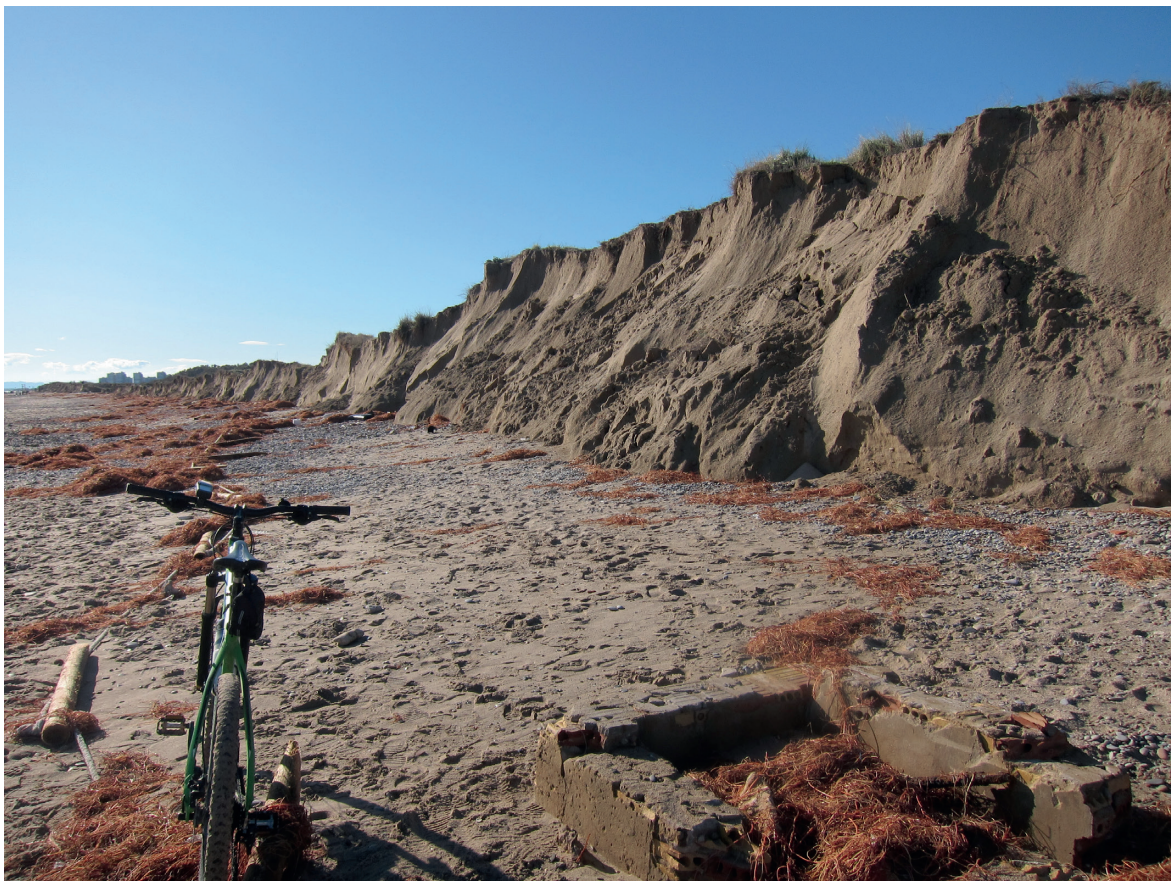
Destrozos causados por el temporal Gloria en el frente de dunas de la playa de El Saler (Valencia). Enero de 2020. Foto: E. Antequera
