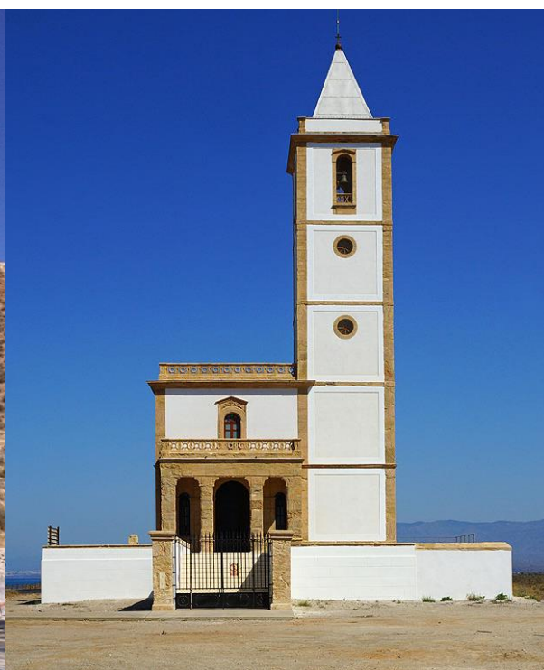
Fotografía: Digby Merry
