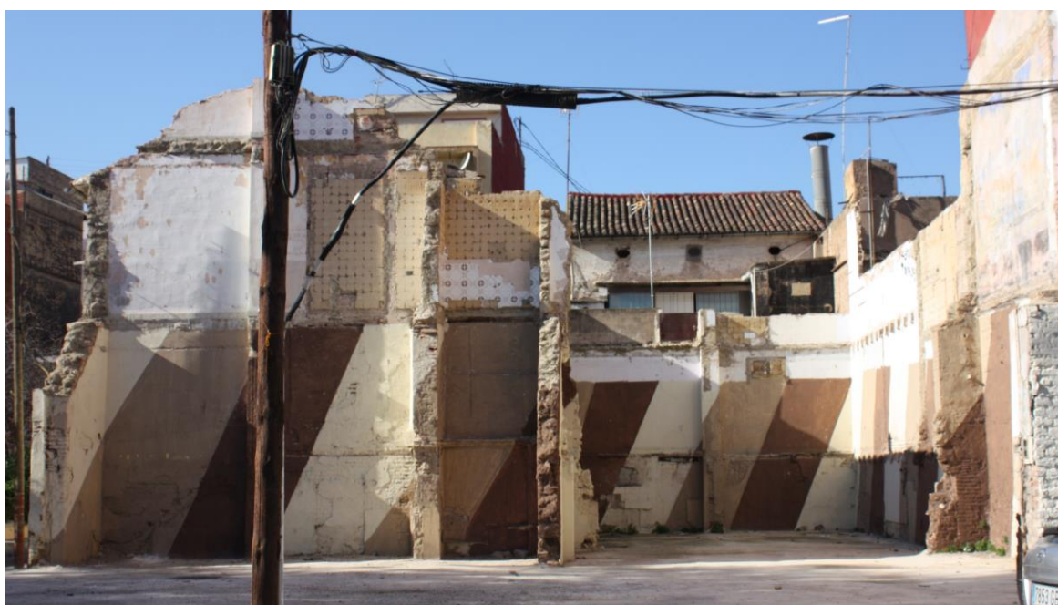
Figura 6. Vista actual edificio derribados por el Ayuntamiento en la calle Escalante. (Pastor, Santisteban y Rodríguez 2014)
