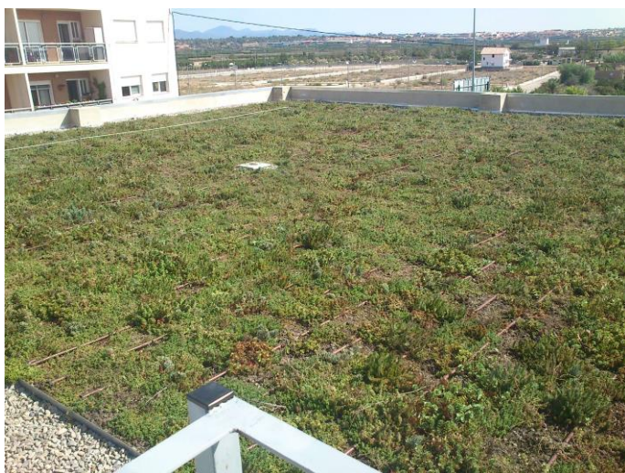
Figura 4. Cubierta vegetada en el edificio multiusos del Ayuntamiento de Benaguasil (Valencia). Proyecto AQUAVAL Fuente: Imagen tomada por José Sergio Palencia.
