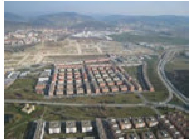
Actuaciones de vivienda pública
