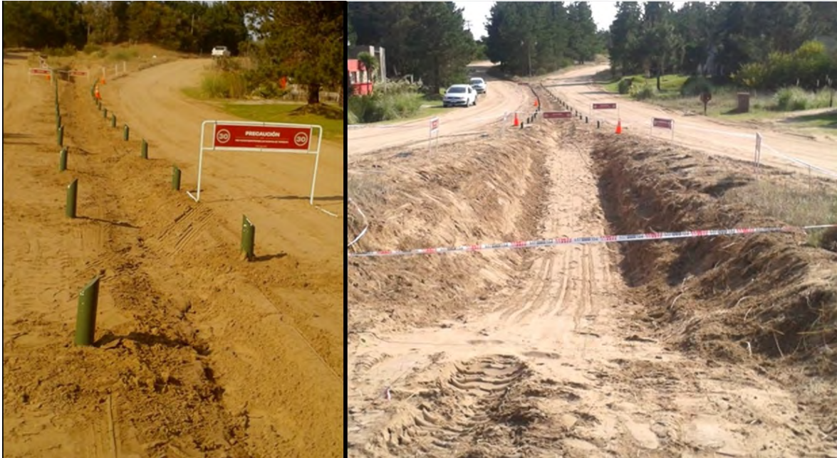
Fig. 9 A-Badén a cielo abierto, B-Dren construido
