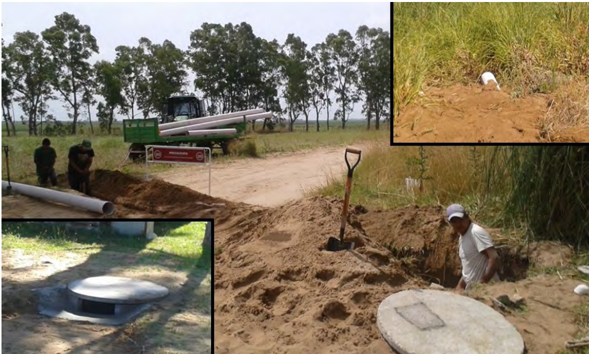
Fig. 8 A-Boca de acceso con pozo de decantación, B-Entubado de PVC tipo Novafort y cámara de inspección en quiebre de traza, C-Dren natural
