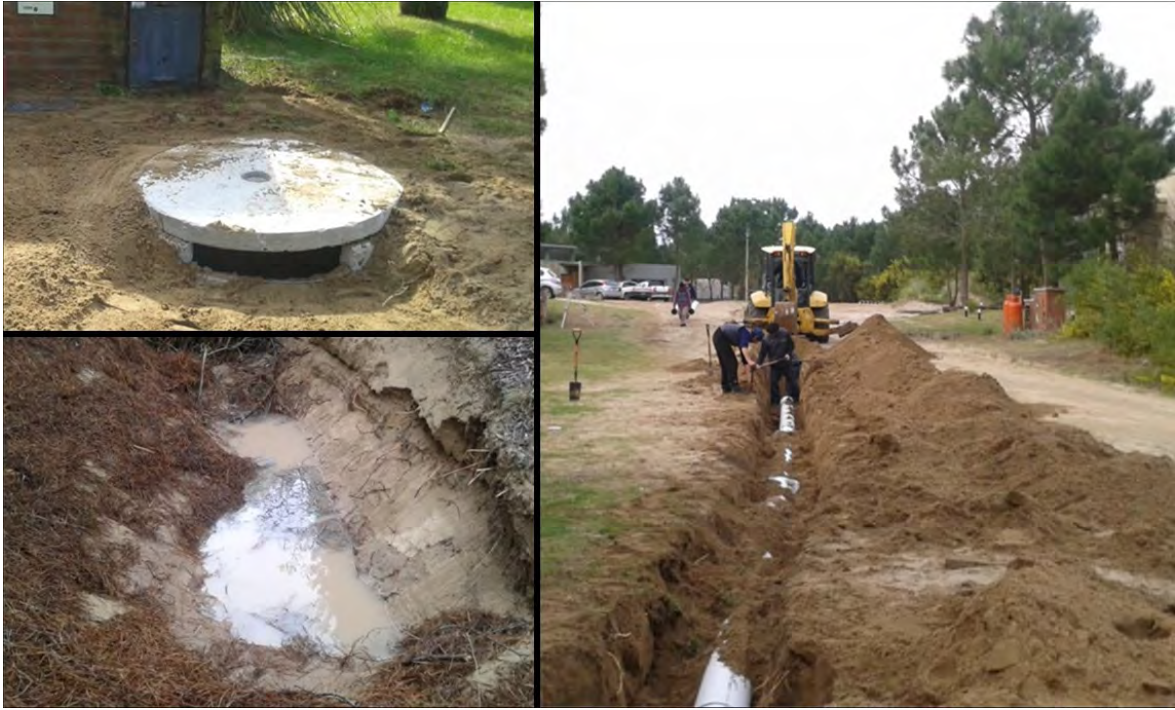
Fig. 7 A-Boca de acceso con pozo de decantación, B-Entubado de PVC Standard, C-Dren construido
