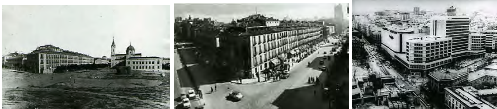
Figura 4, 5 y 6. Madrid. El Barrio de Pozas hacia 1887; El Barrio de Pozas hacia 1960, antes de su demolición; El nuevo Centro Terciario levantado tras la demolición del Barrio de Pozas. Fuente: Postal de la época; Documentos Compañía Metropolitana Madrileña y Fotos de los autores, 1976.
