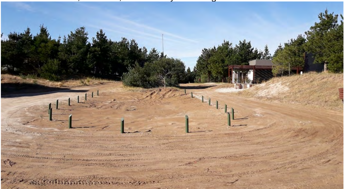
Fig. 10 Dren construido en cul-de-sac
