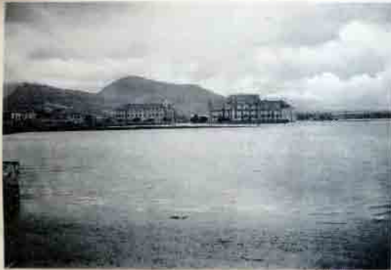
El Arsenal en construcci3n en un segundo puerto de la ciudad
