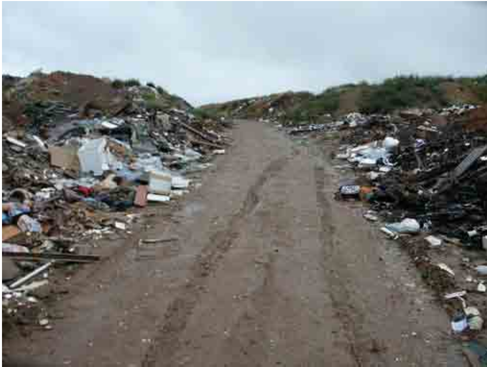
Foto 3. Detalle de escombrera en Campillos
