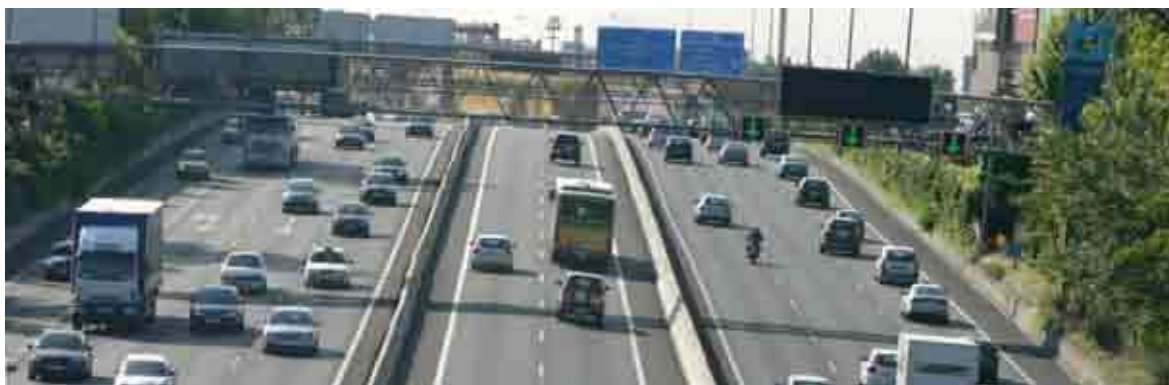
Foto 7: Vista de la A-6 en los accesos a Madrid. Es una vía de gran capacidad que canaliza simultáneamente los tráficos de largo recorrido, de penetración, interurbanos y de agitación en el noroeste del área metropolitana de Madrid (foto Ignacio Español Echániz).
