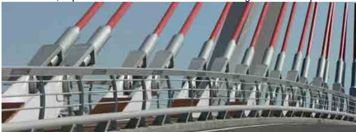
Foto 3. Sistemas de sujeción de los tensores del puente atirantado sobre la A-6 en Las Rozas (Madrid). La estética de la obra pública es mecánica y funcional connota eficacia, capacidad y progreso en contraste con los significados más apreciados en el paisaje que suelen referir a naturalidad e identidad cultural (foto Ignacio Español Echániz).
