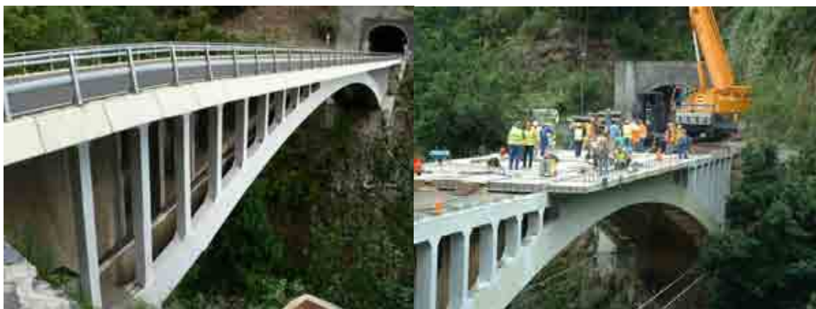
Fotos 13 y 14. Puente del Barranco de La Galga (La Palma). Construido sobre el puente de hormigón existente que se puede observar en su interior (izqda. foto Ignacio Español Echániz), las estructuras laterales y la plataforma lo envuelven (dcha. foto de José Tomás Rodríguez de Paz) aprovechando el trazado de la carretera y su túnel evitando así una actuación mayor.
