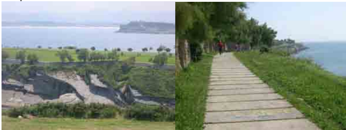
Fotos 11 y 12 .Paseo litoral de Cabo Menor en Santander, con una intervención espectacular por lo muy modesta que es en términos constructivos (foto izqda.). Sin embargo, saca un grandioso partido de las condiciones del sitio, las pone en servicio de los ciudadanos sin grandes costes, pasando desapercibida con elegancia (foto Ignacio Español Echániz).
