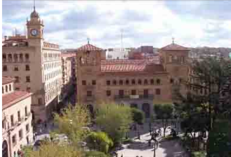
Ilustración 6. Vista general del Banco de España, el Edificio de la Unión y el Fénix y parte del Palacio de Garcigrande. Plaza de los Bandos. Salamanca.
