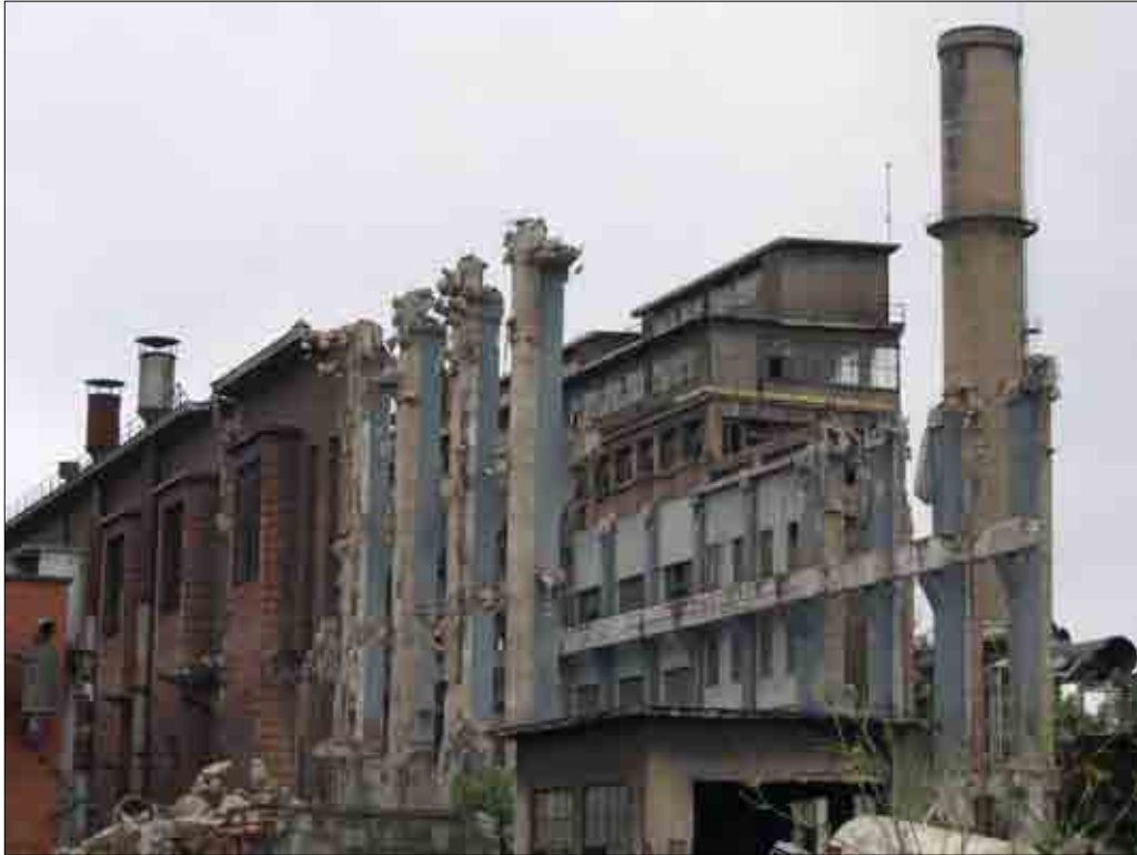
Foto 1. La antigua Central Térmica de Avilés tras el inicio de las obras de derribo.
