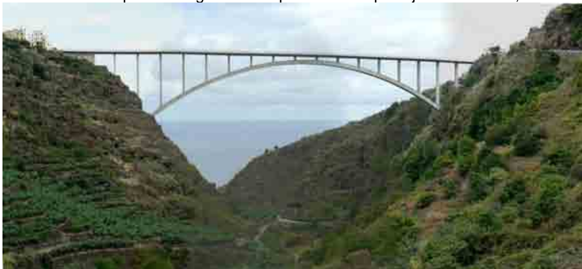
Foto 2. El arco del viaducto de Los Tilos, en Los Sauces (La Palma) descarga el peso sobre las laderas Barranco del Agua con un espectacular desarrollo simple y geométrico, en contraste con los rasgos orgánicos del vano en el que se sitúa (foto Ignacio Español Echániz).
