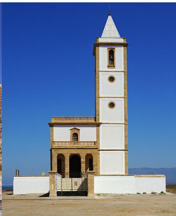
Fotografía: Digby Merry
