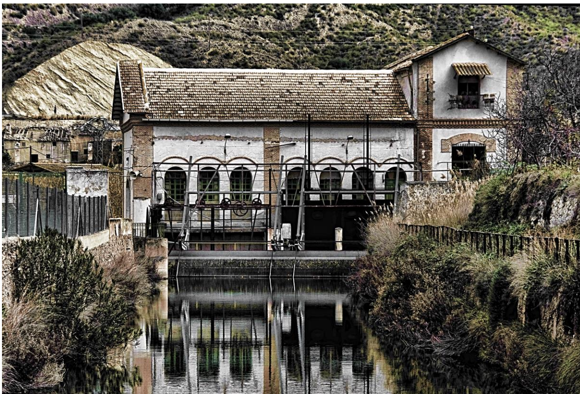
Figura 7. Central hidroeléctrica de D. Nicolás Gómez Tornero, (actualmente de Iberdrola Renovables S.A.U), en la margen derecha del Segura en el paraje del Soto Damián en Abarán. En 1931 tenía un salto de 4,00 metros y una potencia de 1.066 H.P. En el 2008 tenía una potencia instalada de 384 KW.
