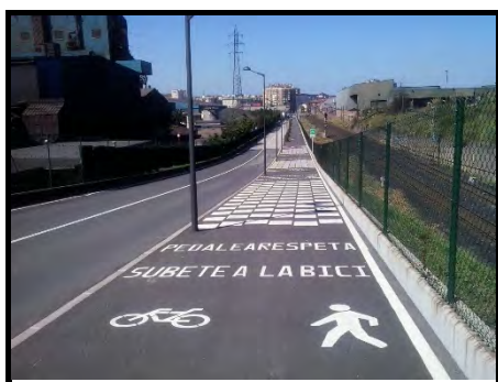
Tramo de la Red BICI.BAS ejecutado recientemente.
