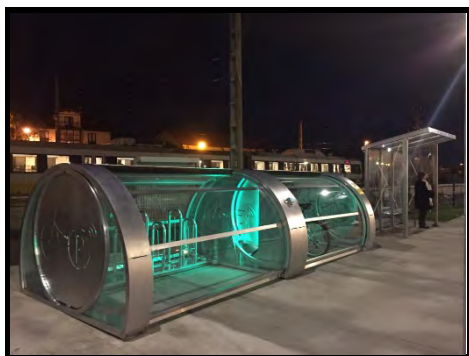
Primer aparcabicicletas automatizado, videovigilado, cubierto y público de Cantabria
