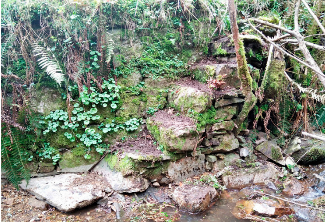
Figura 5. Escalera al río de piedra seca.
