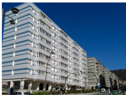
Intervención en fachada en Txurdinaga (Bilbao).
