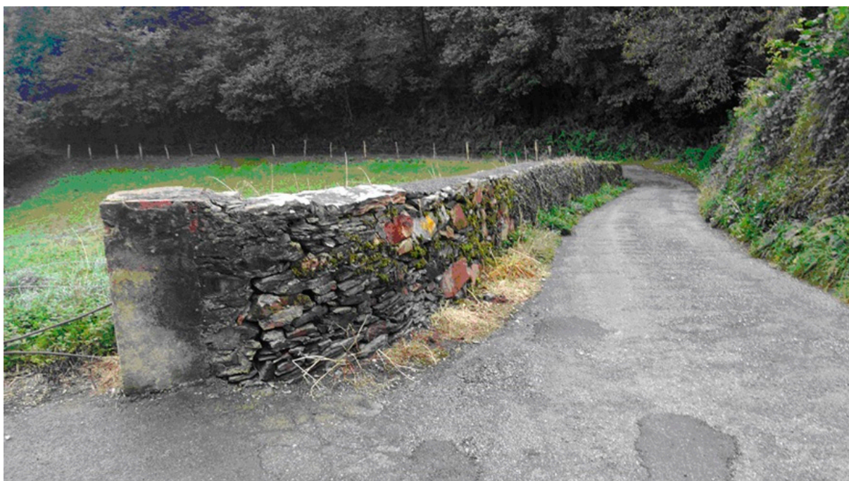
Figura 7. Muro de piedra seca alterado por la incorporación de nuevos materiales en el Camino de Santiago a su paso por La Preda y La Miariega. Fotos facilitadas por el Ayuntamiento de Tineo.
