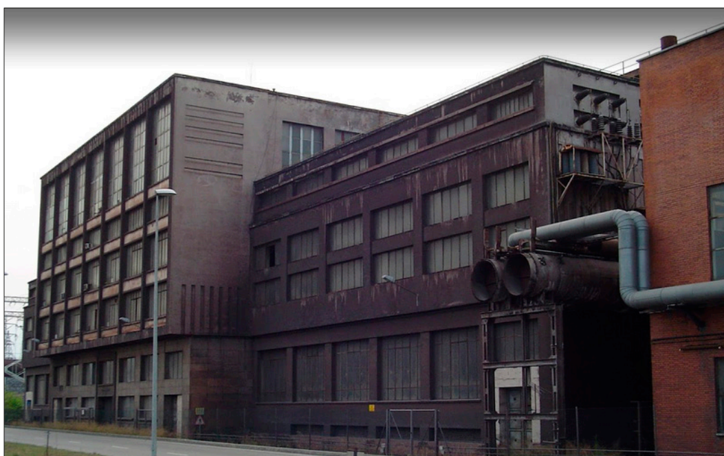
Figura 1. La antigua Central Térmica de Ensidesa, antes de su demolición definitiva. Autor: Fernando Cosmea.
