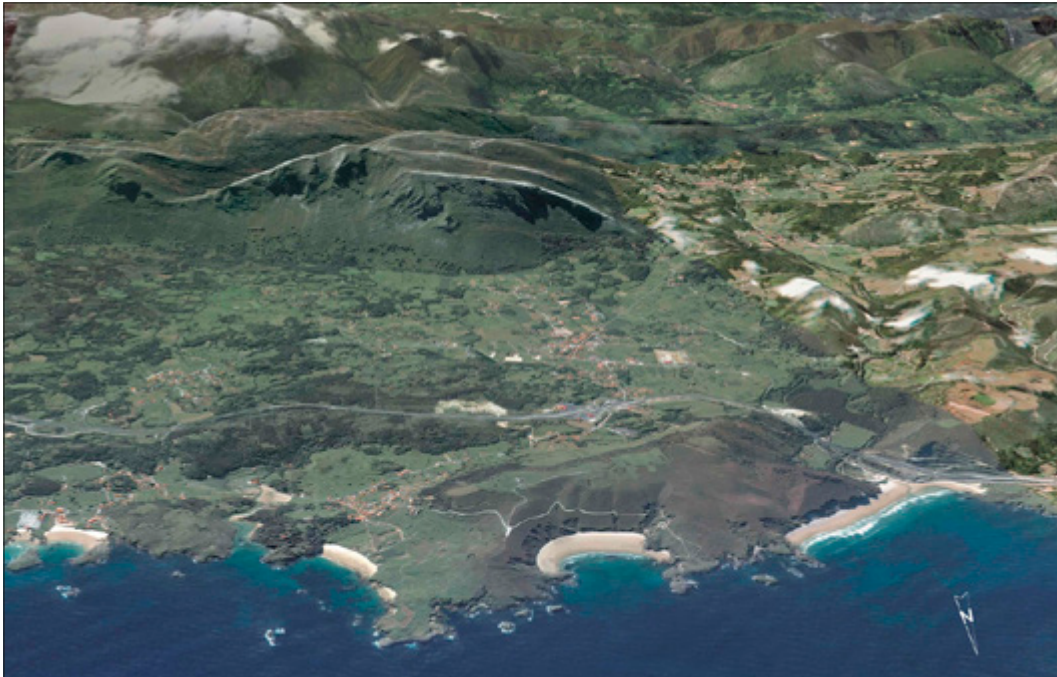
Figura 3. Imagen expresiva del impacto ocasionado por el trazado de la autovía del Cantábrico A-8 a su paso por Posada de Llanes (imagen de Google Earth , 2015).
