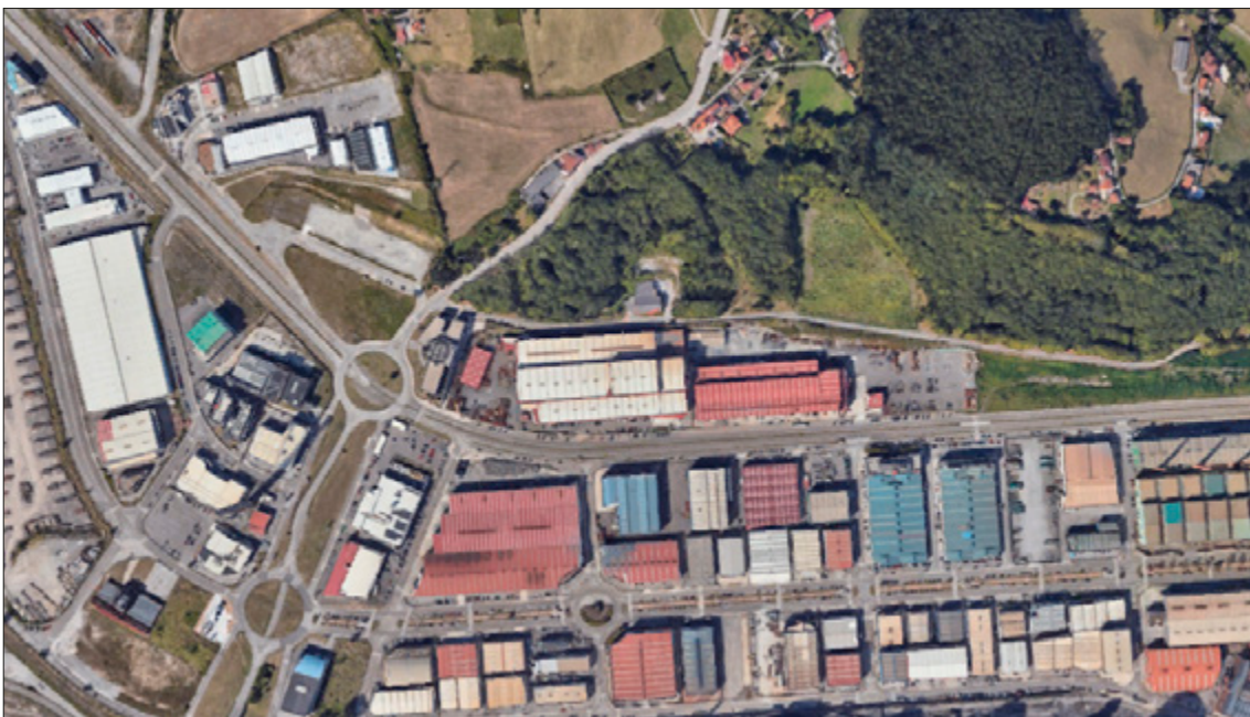
Figuras 2 y 3. Los terrenos de la antigua Central Térmica de Enxidea, en 2007 (superior), antes del derribo, y en 2022 (inferior) con la configuración actual. Fuentes: Plano de estructura parcelaria del Plan Especial APR E-3 (Ayuntamiento de Avilés, 2008) e imagen satelital obtenida de Google Earth.
